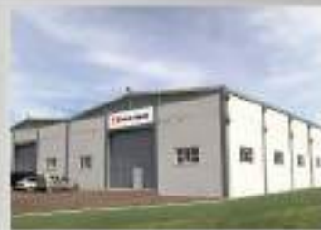
2013-Ölçü Masası Fabrikası 2013-Worktop Board Factory
