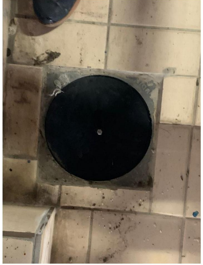
Ek 9 çözeltisi hazırlama bölümünde kostik ve hidroklorik asit depolanır (Kimyasal siloların ikincil kapları olmadan) (Kimyasal siloların ikincil kapları olmadan) Denetçi yorumları ve bulguları - Çevresel Performans Sayfa 31
