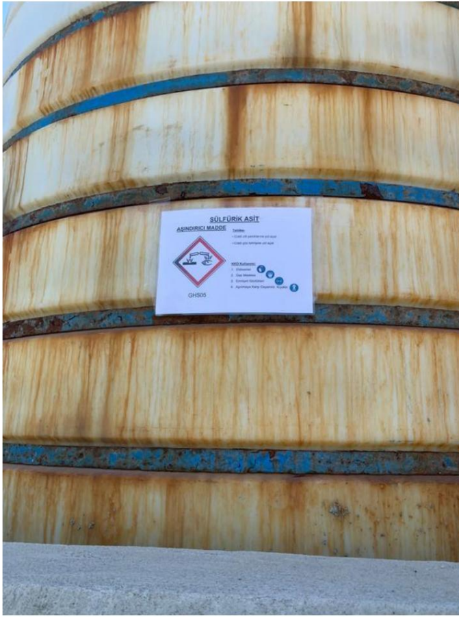
Ek 5 (Atıksu arıtma tesisinde GHS sembollü sülfürik asit.jpg) Denetçi yorumları ve bulguları - Çevresel Performans Sayfa 30
