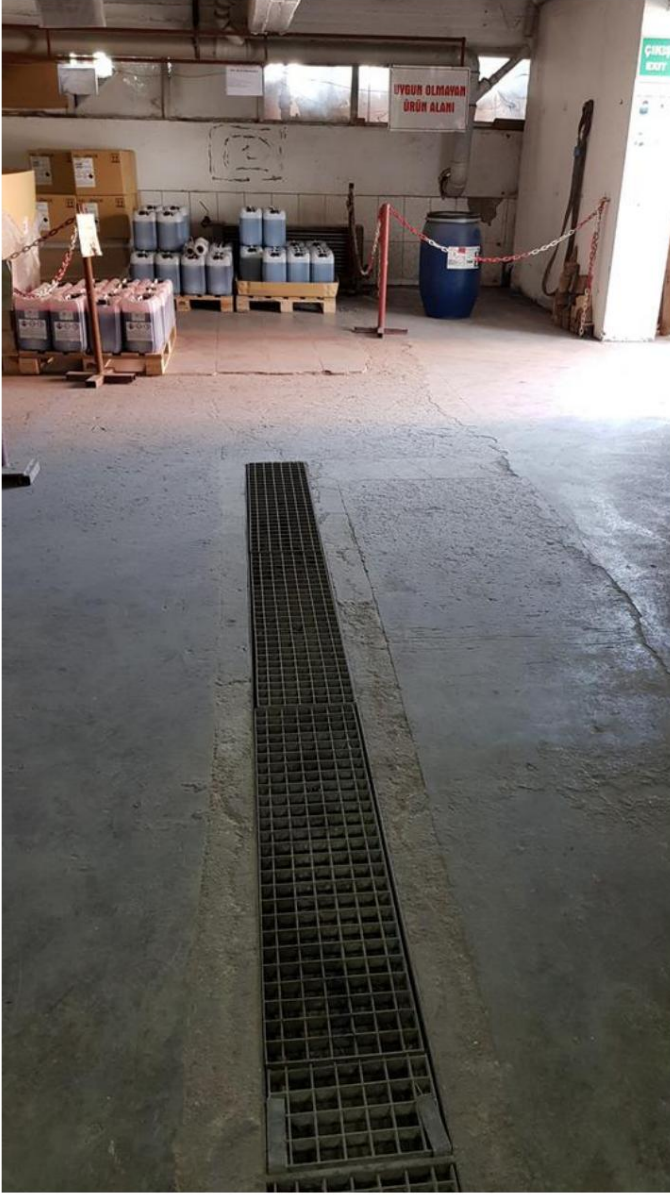
Ek 11 Ek 12 (Drenaj sistemi ana atıksu arıtma giderlerine baėlanmaktadır (Yanıci depodaki drenaj kanalları boru tapalı.jpg) kimyasal ambar.jpg)
