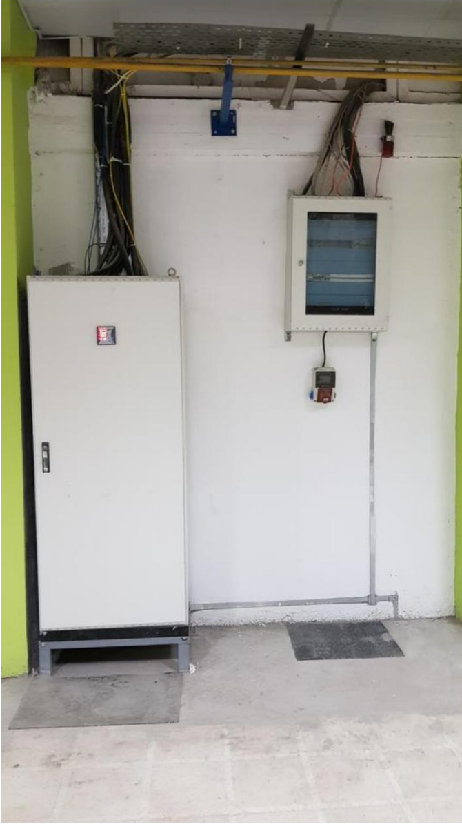
Ek 35 (Kauçuk paspaslı kapalı řalter dolapları.jpg) Denetçi yorumları ve bulguları - Saęlık ve Gvenlik Sayfa 57
